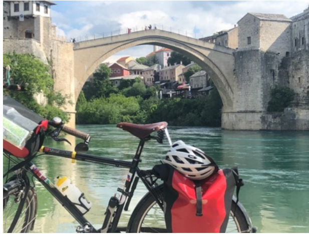
Abbildung 10 - Am Fuße der Brücke von Mostar
